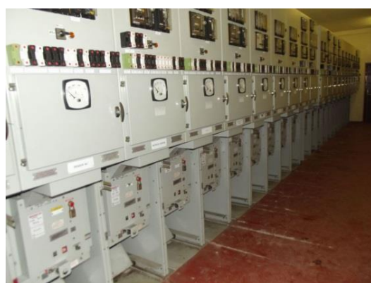
Hawkgas HG12 11 kV switchgear
